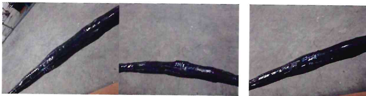
с) Муфты соединительные термоусаживаемые 10СТп(М)-3×(150-240)
