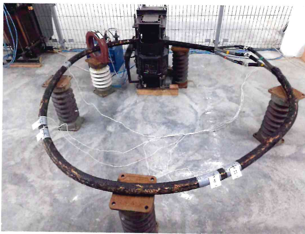
б) Контрольный образец кабеля на напряжение 10 кВ
