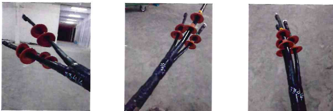
б) Муфты концевые термоусаживаемые наружной установки 10КНТпН-3×(150-240)
